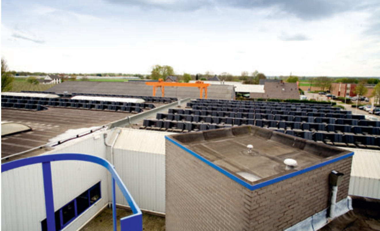
De pv-panelen op het dak leveren de benodigde energie voor de warmtepomp.
